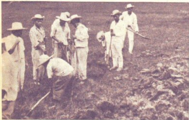
Una escena de la iniciación de los trabajos del estanque...
